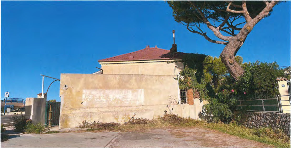
Etat existant_vue depuis le parking
