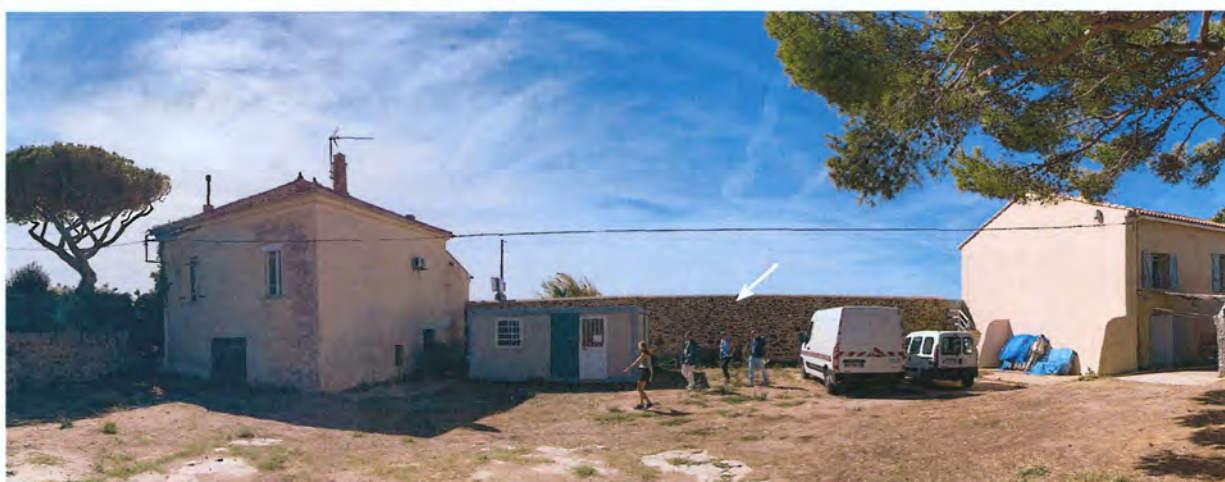
Vue de la cour existante. Le niveau de sol sera remblayé d'environ 90cm ce qui contribue à la conservation des niveaux archéologiques, et permet également d'assurer le lien avec l'altimétrie de l'espace public extérieur. Le mur de clôture coté route sera conservé et restauré.
