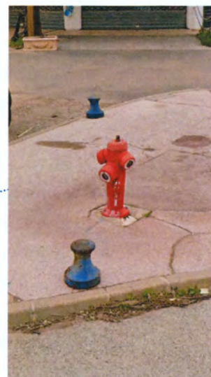
Borne d'incendie PI HRS 511
