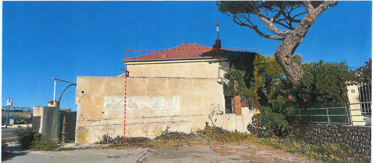
Vue depuis le parking et depuis la route de l'Almanarre du futur accueil-boutique. Les extensions de l'actuelle maison du Dr Gaudet seront démolies. Le bâtiment sera détoituré et surélevé. L'ensemble de l'espace intérieur sera évidé.
