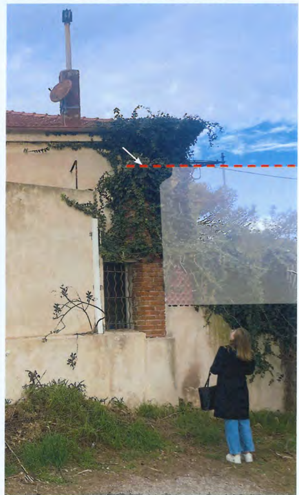
Arrivée du mur mitoyen Est coté espace public, contre le pilier brique et chapiteau pierre conservé
