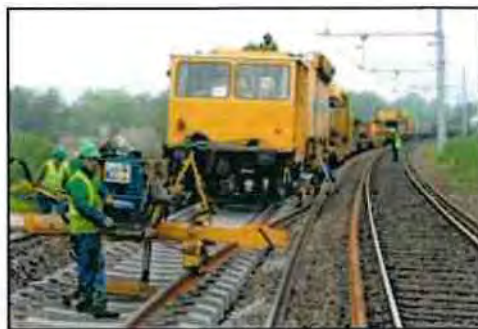
Longs Rails soudés sur traverses béton
